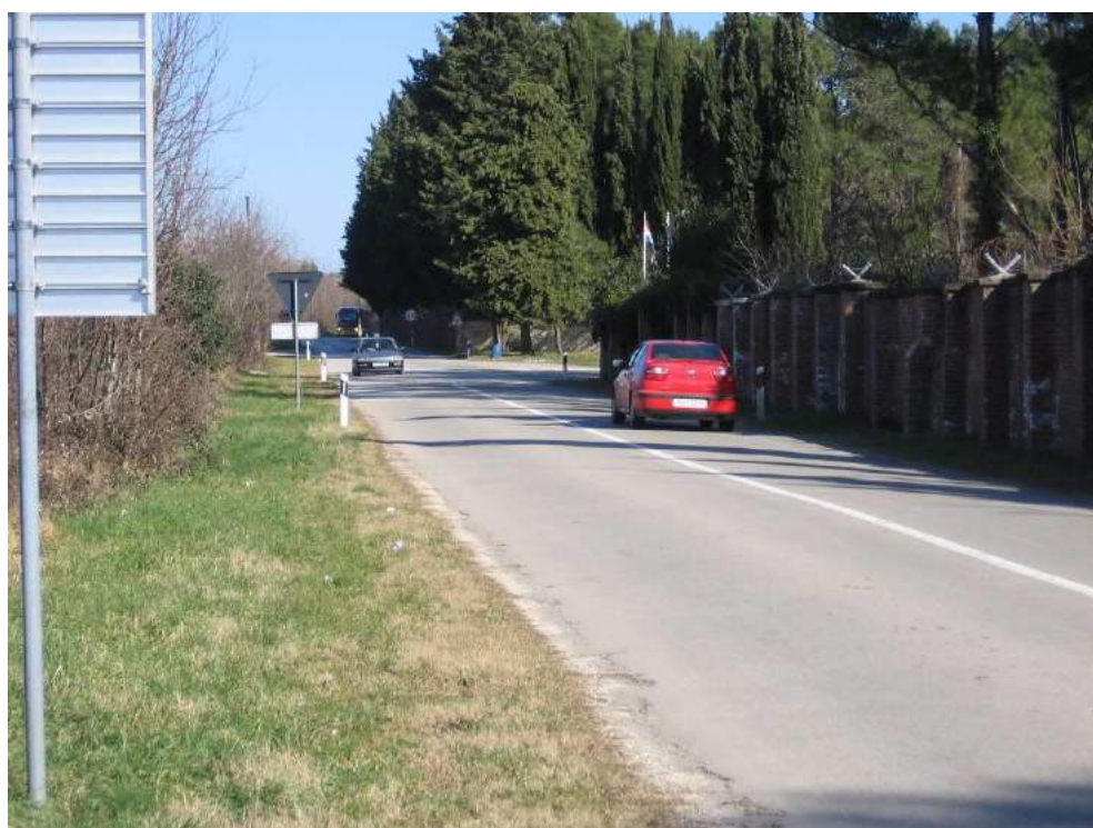
Slika 4. Državna cesta D401 od raskrižja sa ŽC5120, pogled prema zračnoj luci (zid vojarne s desne strane)
